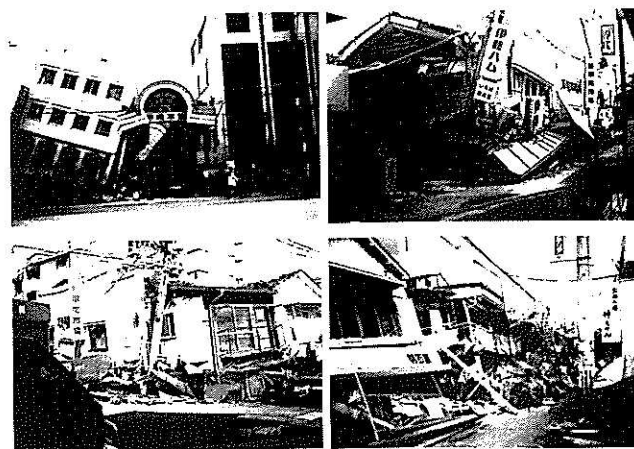
新甲南市場周辺の震災直後の状況
