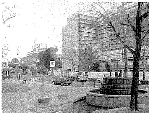
写真－６ 解体前の市民会館・温泉プール（手前仮囲い）
