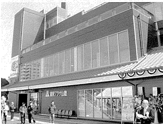
写真－５ 減築切断面の補強と化粧
