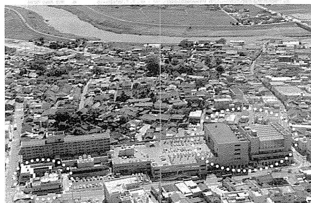
建物の解体部分
