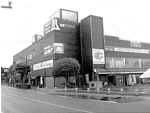
写真－４ 減築による切断面の化粧（手前の解体敷地にさくら湯を復元・建替え）
