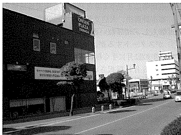
△ 整備後の再開発ビル（向う側の空間が解体部分）
