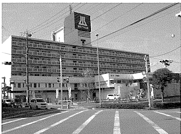
△ 手前にあった建物を解体、広場・駐車場として整備
