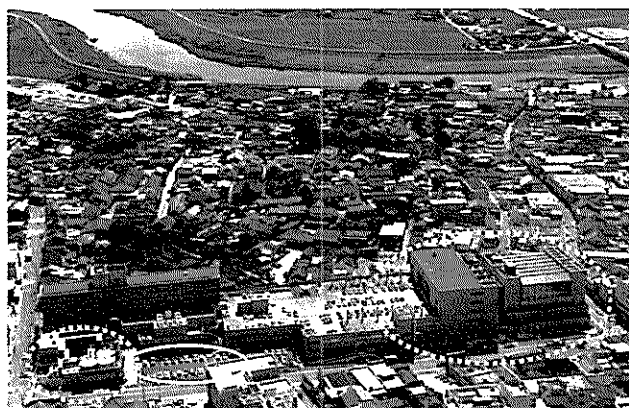
○ 建物の解体部分 ○ 平面駐車場を立体駐車場に △ 再開発ビル全景
